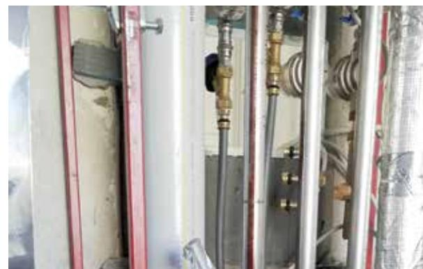
*Sichtbare Veränderungen, die nicht sichtbar sind: Links die alten Abwasserrohre, rechts die neuen Steigestränge.*
